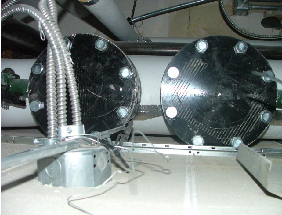
Figure 7.1-2 : Aménagement fait au système de refroidissement pour accommoder un test alpha.
