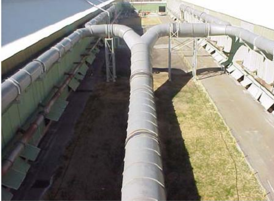
Figure 6.2-2 : Conduit de gaz en provenance d'une fonderie d'aluminium (Roe, 2006)
